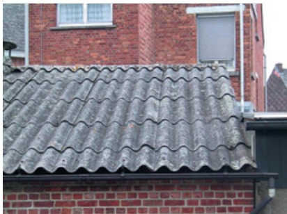
Voorbeeld hechtgebonden toepassing: golfsplaten
