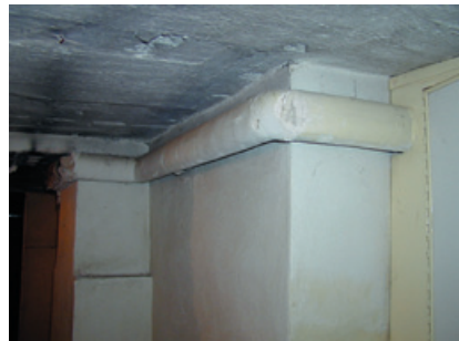
Voorbeeld ongebonden toepassing: plasterislatie
